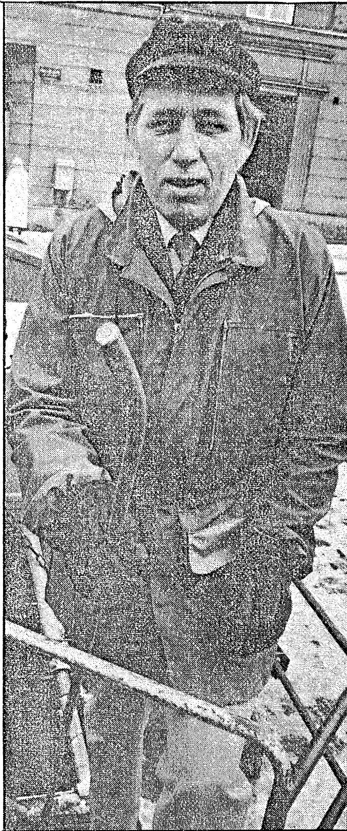
Sune Larsson, televerket, med första TV-kabeln, som läggs ner i landet
